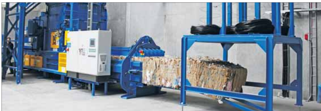
Nowoczesny zakład Centrum Zagospodarowania Odpadów „Selekt” obsługuje 17 gmin.
