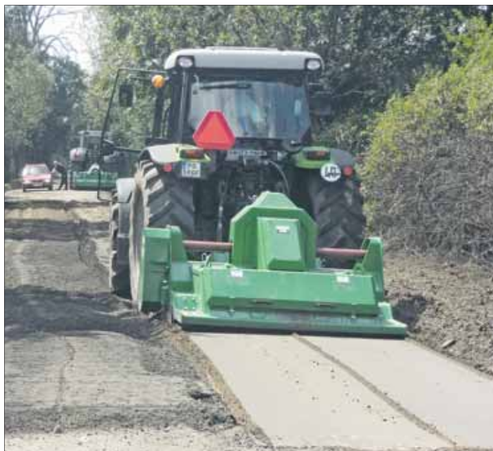
Pokaz niemieckich maszyn utwardzających gruntowe drogi odbył się na drodze Dopiewo – Podłoziny.
