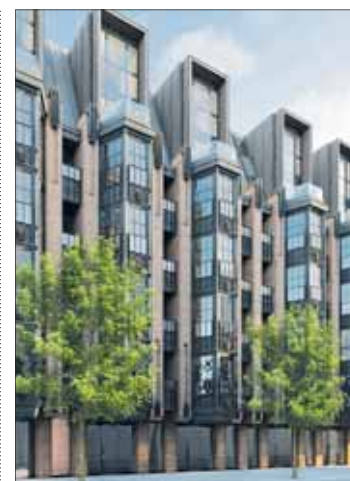
Perła to 7-kondygnacyjny budynek mieszkalny.
