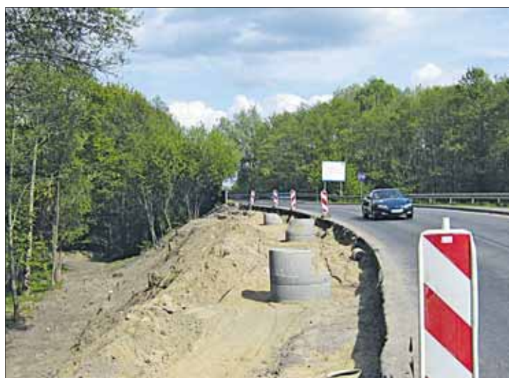
Trwa przebudowa drogi w Biedrusku.
